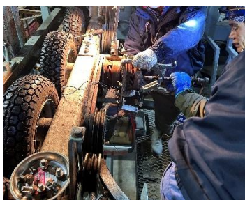
(支柱受索輪交換・出発クラッチ交換・ユニバーサルクロスベアリング交換)
