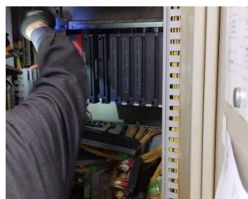
(油圧緊張ユニット更新・ゴンドラ制御シーケンサ更新・主減速機オイル交換)
