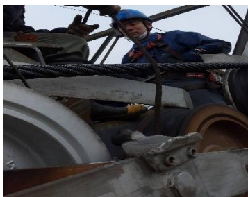
(支柱受索輪交換・出発クラッチ交換・ユニバーサルクロスベアリング交換)
