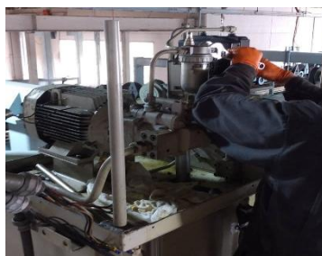
(油圧緊張ユニット更新・ゴンドラ制御シーケンサ更新・主減速機オイル交換)
