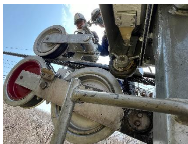
(支柱受索輪交換・脱索防止装置交換・索輪整備)
