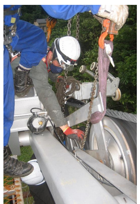
(支柱索輪交換)
