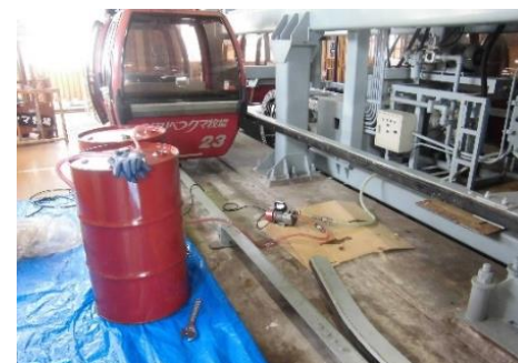
(主減速機オイル交換)
