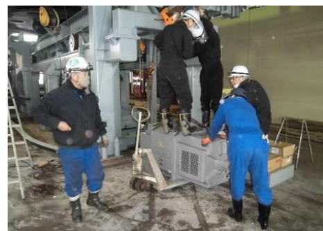
(整備済み電動機取り付け作業)
