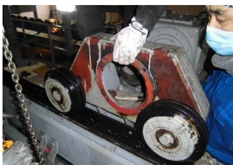
(駆動装置軸受け交換作業)
