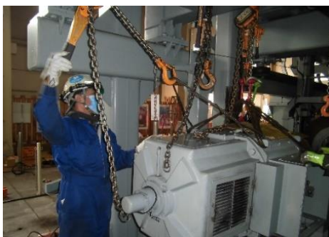
(電動機取り出し作業・整備前)
