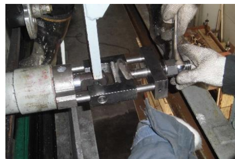
(山頂到着装置ベアリング交換作業)
