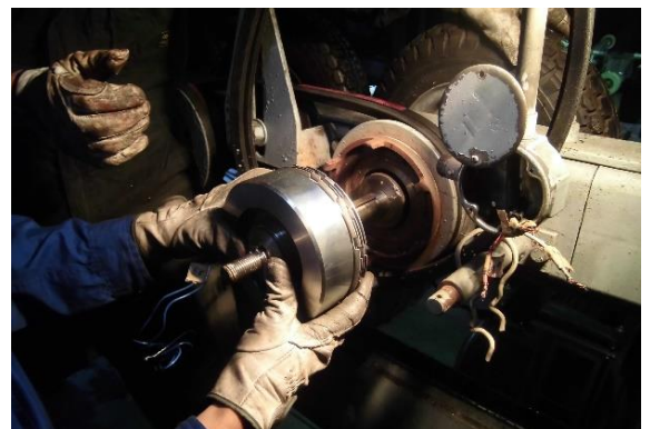
(山頂出発クラッチ交換作業)
