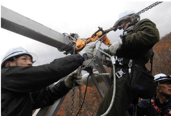
(メッセンジャーワイヤー交換作業)
