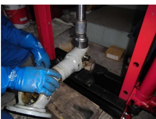
(場内押送自在継手軸受交換作業)
