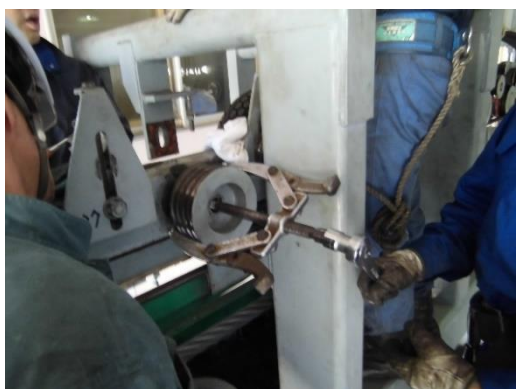
(場内押送装置軸受交換作業)
