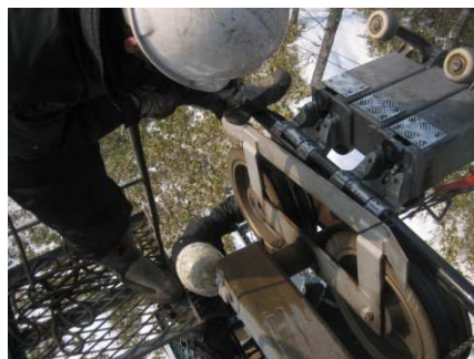
(線路支柱索輪交換作業)
