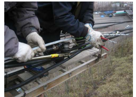
(線路通信線補修作業)
