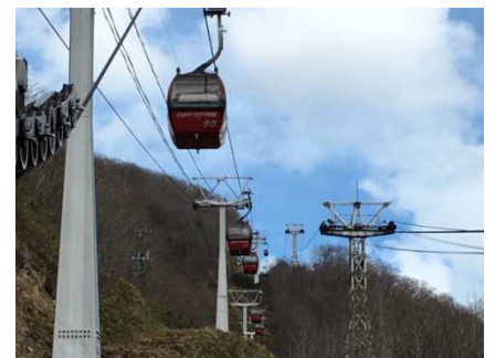
(荷重制動試験 上り 100%下り 0%)
