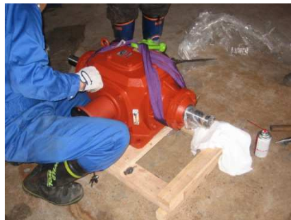
(ギヤボックス交換作業)
